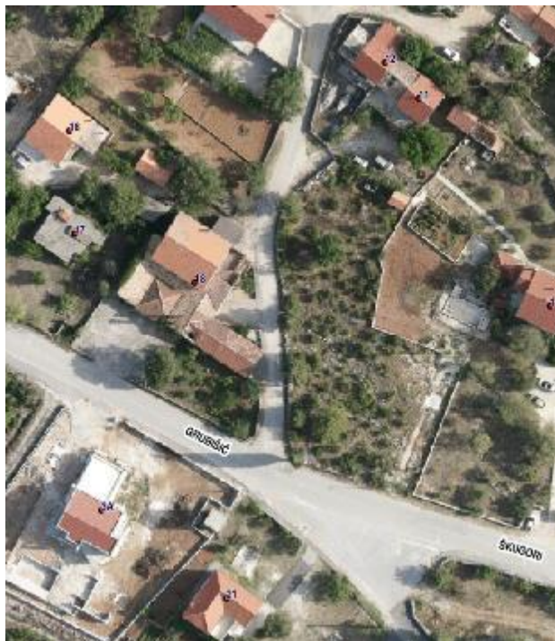
Fotodokumentacija nakon izvedenih radova sanacije asfaltnog kolnika Dubrava – predio Grubišići
